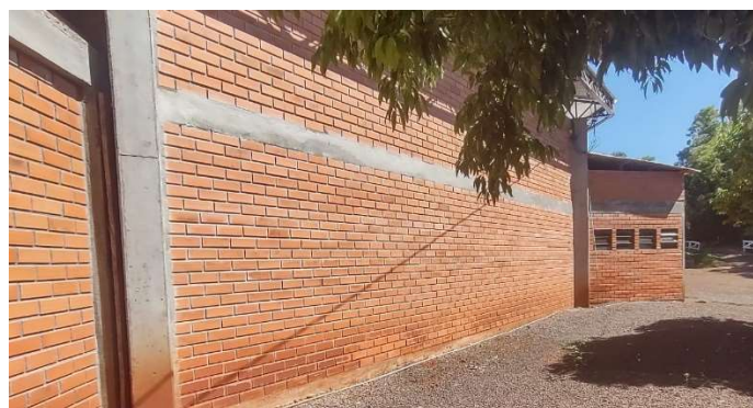
Figura 5 - Imagem de alvenaria existente do centro de eventos
